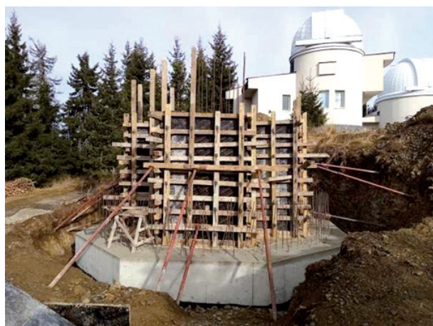
Фундаментът на новия 1.5 м телескоп
